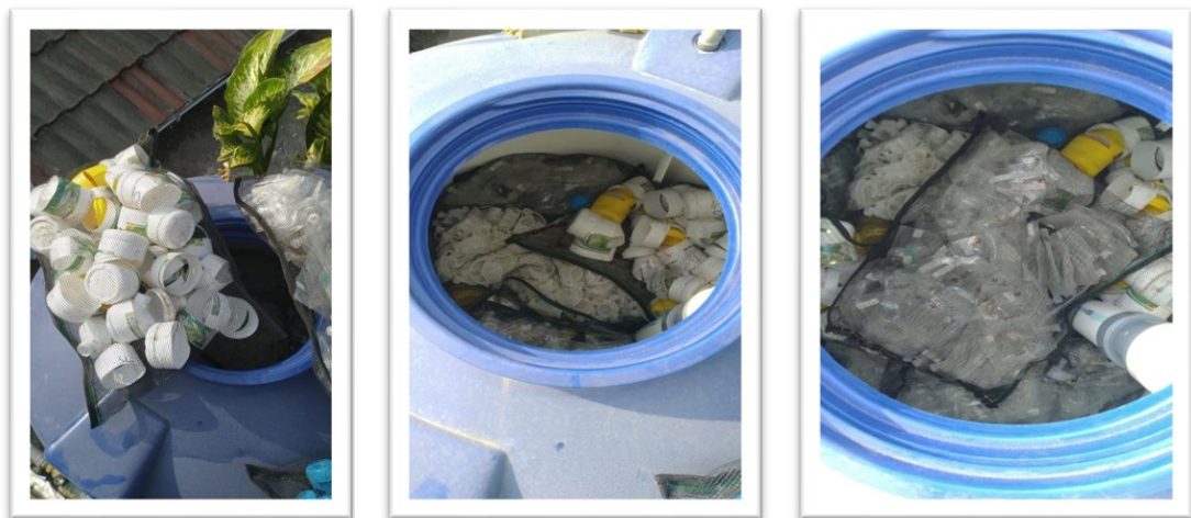
Gambar 5. Pemasukan biofilter (cacahan plastik bekas) dalam tandon IPAL
