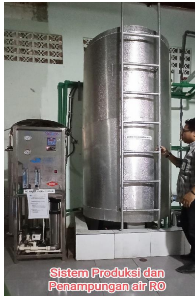
Gambar 4.6 Peralatan Sistem Produksi Air RO
