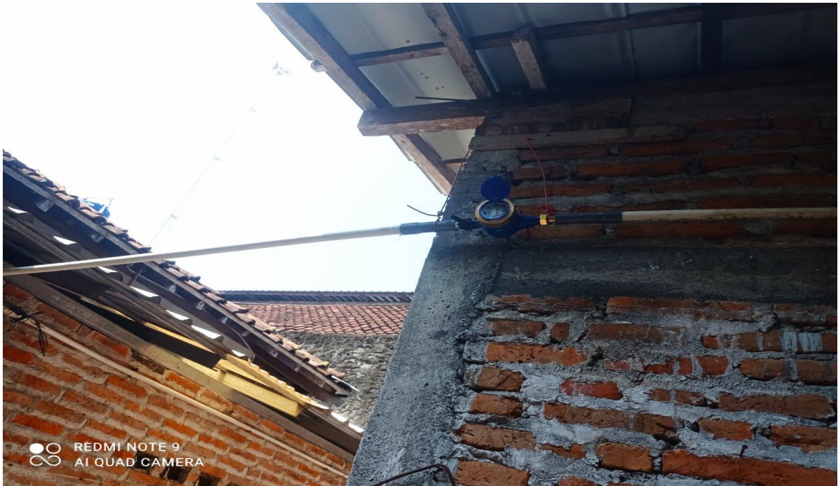
Dokumentasi : Instalasi air bersih + water meter ke rumah Ny Suprapti + Bp Yuli P. (barat RS)
