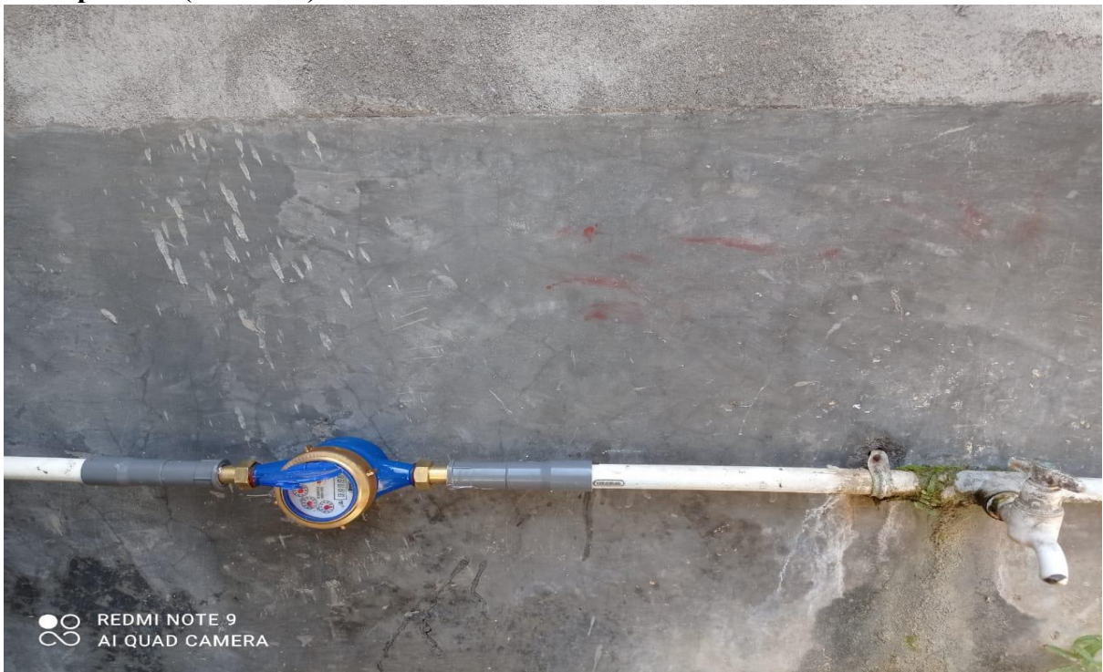
Dokumentasi : Instalasi air bersih + Water Meter ke rumah Bp Edi Wisnantoro dan Bp Jazim (timur RS)
