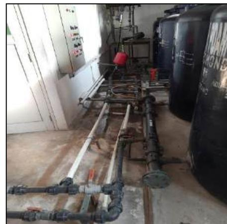
Gambar 2. Jalur Distribusi Air Limbah Untuk Air *Flushing*
