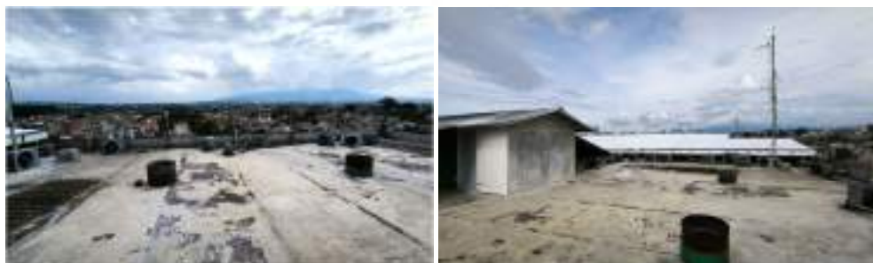
Gambar 3. Rooftop sebelum instalasi hidroponik
