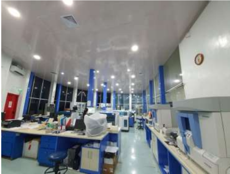
Gambar 1b. Kondisi plafon ruang laboratorium setelah perbaikan
