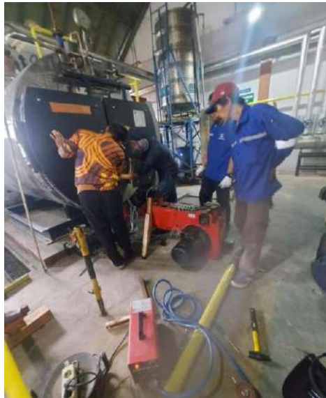
Gambar 1. Pekerjaan Penggantian Burner
